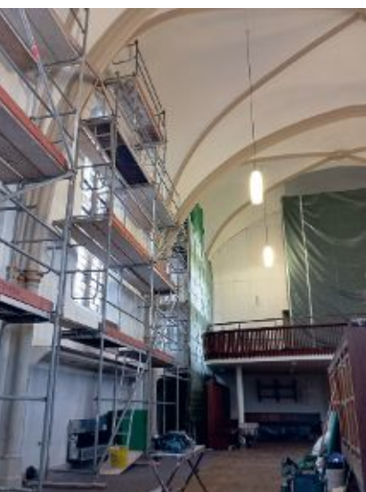
Zur Renovierung der Kirche mussten hohe Gerüste aufgestellt werden Foto: R. Hufschmidt
