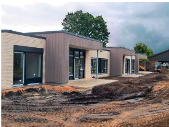
Die neue Kindertagesstätte in Mesum im Bau Foto: B. Meyhoff
